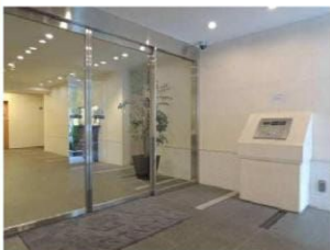
カスティア東日本橋風除室
